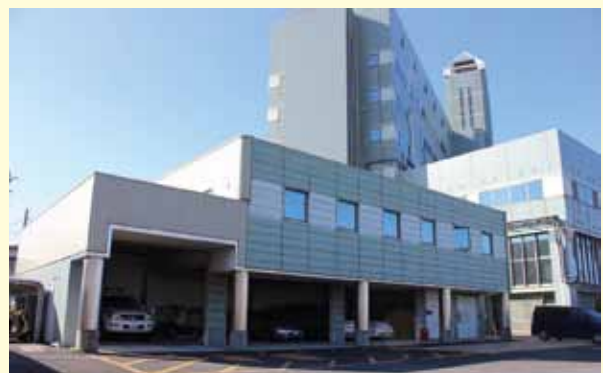
●鳩ヶ谷庁舎別棟
