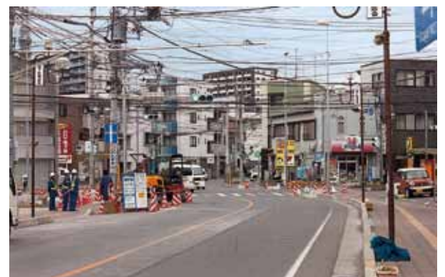
●右折帯の設置工事
