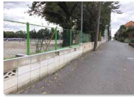
鳩ヶ谷中学校のブロック塀は危険部分の撤去を完了
