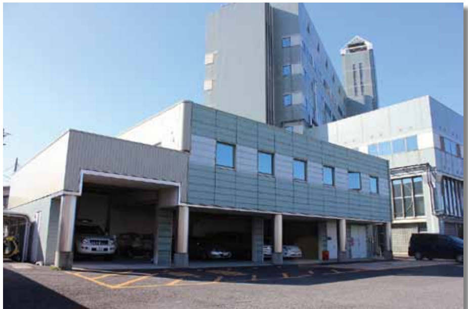
鳩ヶ谷庁舎別棟
