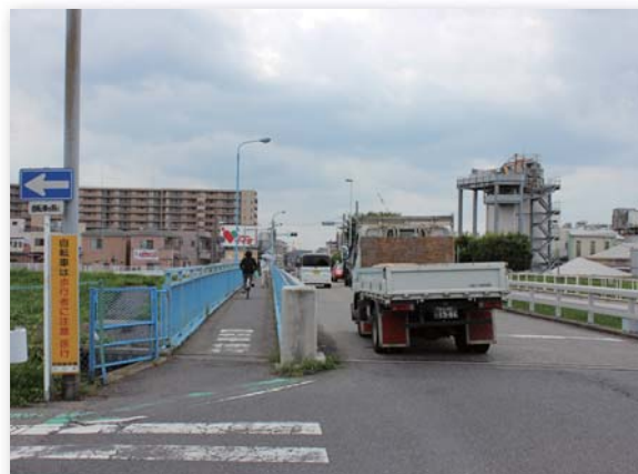
●他の橋に比べ、汐入橋の歩道橋部分は狭い
